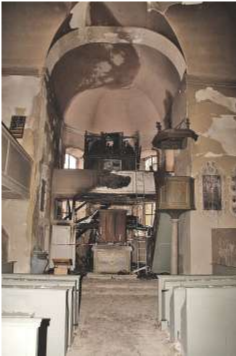
Das Bild zeigt den zerstörten Altarbereich, die verbrannte Orgel und die Schäden im gesamten Kirchenschiff.
