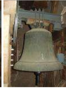
Die kleine Glocke gegossen zwischen 1425 und 1450 Nominalton: d + -12 Durchmesser: 83,6 cm
