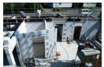
Blick in die neue Krippe (von oben)
