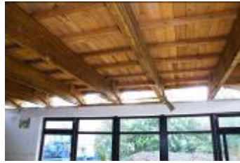
Demontage des Daches - Innenansicht nach Ausbau der (recht mageren) Isolierung - Zerlegung der Dachelemente am Boden
