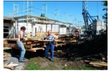
Demontage des Daches - Innenansicht nach Ausbau der (recht mageren) Isolierung - Zerlegung der Dachelemente am Boden
