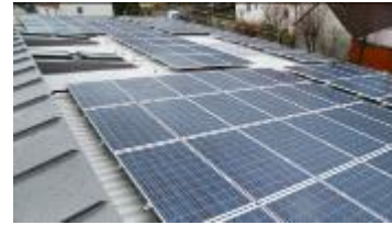
Die Module auf dem nordwärts- und dem südwärts geneigten Dach
