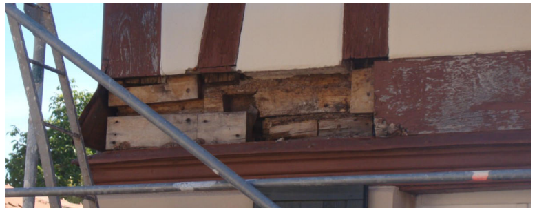
Pfarrhaus Marktbergel: Hinter einer Verbretterung waren verfaulte Balken verborgen. An etlichen Stellen ist das Fachwerk nicht mehr in Ordnung.
