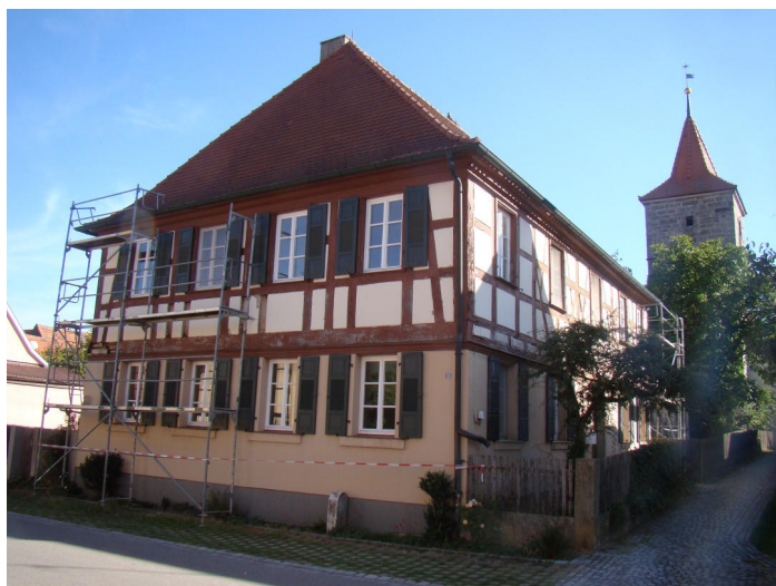
Das Pfarrhaus in Marktbergel hat schon bessere Tage gesehen und wird hoffentlich bald wieder richtig gute Tage erleben.
