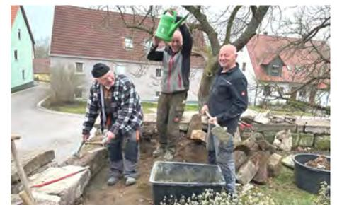
Zunächst wurde der üppige Efeubewuchs entfernt. Dicke Wurzeln wucherten aus den Mauerfugen, so dass die obere Steinreihe teilweise entfernt werden musste, um die Zwischenräume von den Wurzeln zu befreien. R. Braun hat einen Sandsteinquader gespendet, der wegen der vielen Bruchstücke als Ersatz notwendig war. Beteiligt an den Arbeiten waren W. Horn, G. Seemann, W. Endres, R. Hufnagel, E. Schlotthauer, E. Billenstein.
