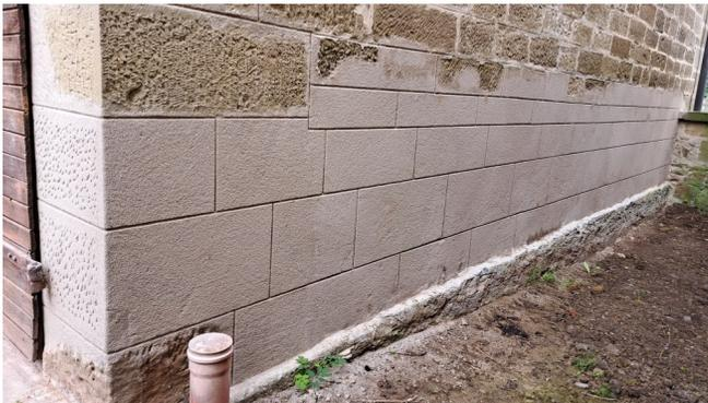
Das Foto oben zeigt das Nebengebäude, an dem der Sandstein durch Niederschläge und Frost großen Schaden genommen hatte. Die bisherigen Ausbesserungen am Mauerwerk mit normalem Zement haben dazu geführt, dass der Sandstein schneller verwitterte als der Zement. Dadurch entstanden Wasserkanäle, die eine noch schnellere Verwitterung des Sandsteins verursachten.
